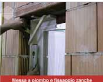
Messa a piombo e fissaggio zanche
