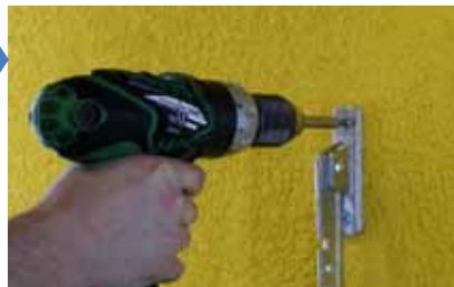
Avvitare l'elemento da montare
