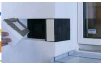
Concludere il montaggio del cappotto e stendere l'intonaco
